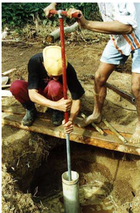
Figura 6.13 – A perfuração dos poços.
