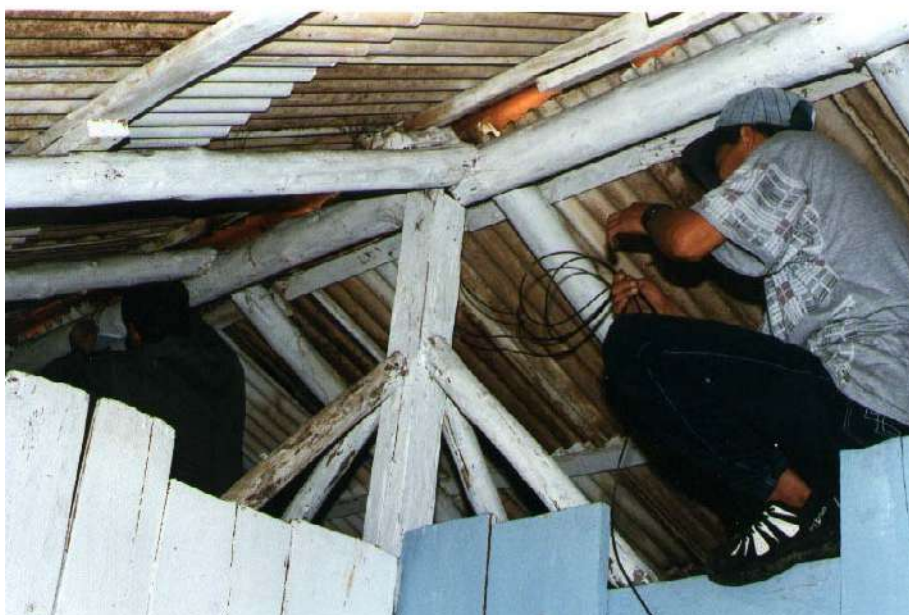
Figura 6.11 – O trabalho interno das instalações domiciliares no Retiro.
