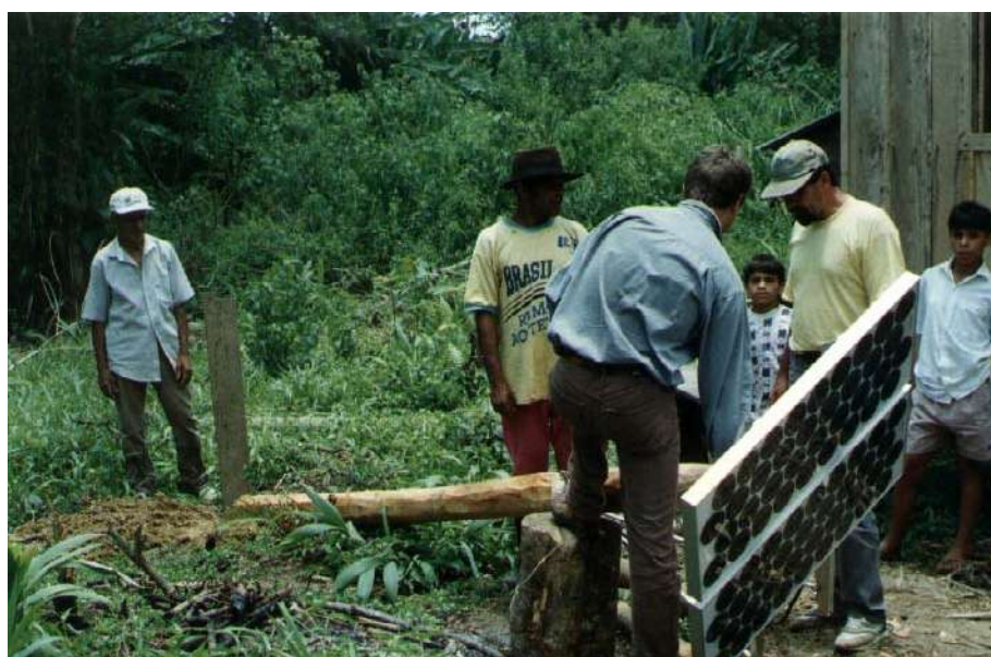
Figura 6.7 – O trabalho de eletrificação da escola do Varadouro.
