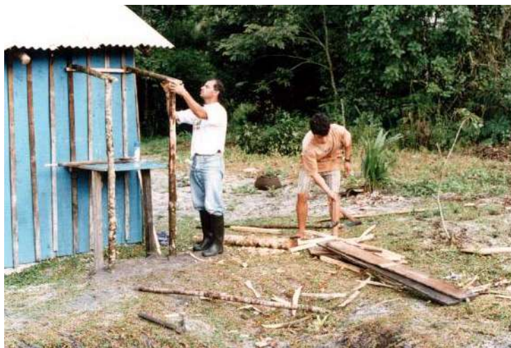
Figura 6.9 – A construção da casa de bateria.
